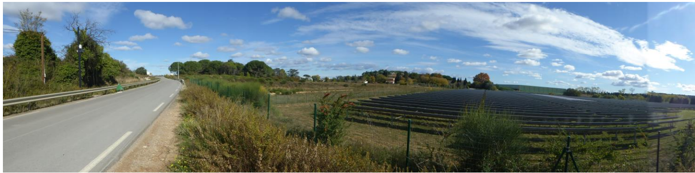
Photo 4- Parc photovoltaïque existant de la compagnie du vent
